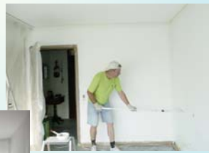
Schritt 3: Fenster mit Abschirmstoff NOVA ausstatten.
