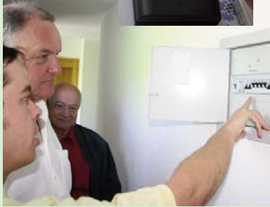
Aussortieren der belastenden Sicherungen (in der Regel 2 bis 4 Stück) Sanierung durch späteren Einbau von Netzfreeschaltern
